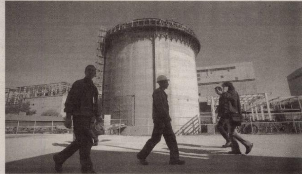
Inițial se prevedea construirea a cinci reactoare nucleare în România. În varianta finală au rămas doar două
